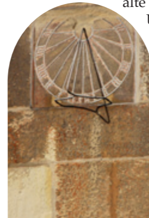
Abb. 3: Sonnenuhr an der Südseite von St. Clemens
